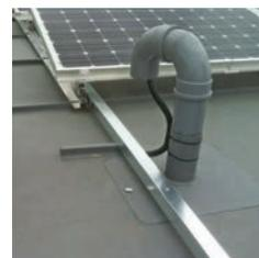
Os fixadores Bi-Metal de aço inoxidável EJOFast JF3-2-5,5 x 25 S16 da EJOT também provaram ser um método limpo e eficiente de instalação de suportes e seções na seção de caixa de alumínio de 2 mm da EJObar.
