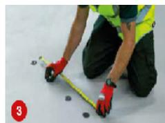
3 Aplicar fixadores corretos para a aplicação nos centros determinado por um cálculo de carga de vento, se necessário.
