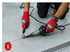
5 Solde o reforço de cobertura da membrana que deve ter 180 mm de largura para vedar sobre a linha de fixação, levando pressão fora da membrana existente.
