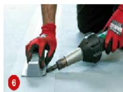
6 Solde a EJOBAR no centro da membrana, diretamente sobre a linha de fixadores.
