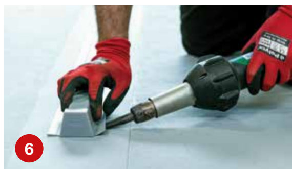
6 Faça a soldagem a quente do "EJOBAR TPO 2G" no centro da membrana, diretamente sobre a linha de fixadores.
