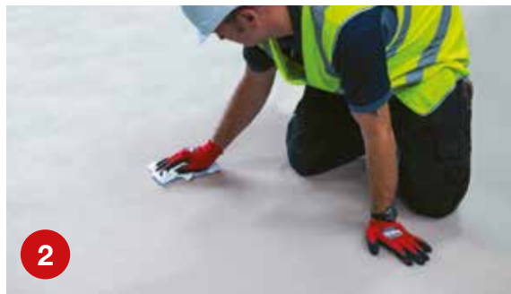
2 Limpe a superfície com a solução apropriada, conforme recomendado pelo fabricante da membrana.
