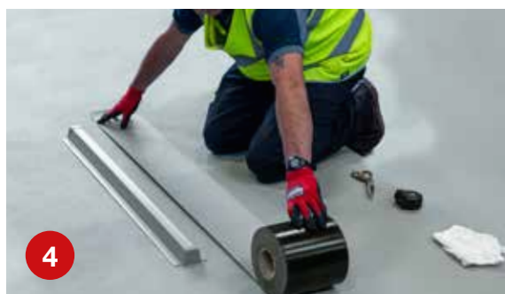
4 Prepare uma tira de cobertura de membrana compatível, arredondando as extremidades, 100 mm mais longa que a barra.
