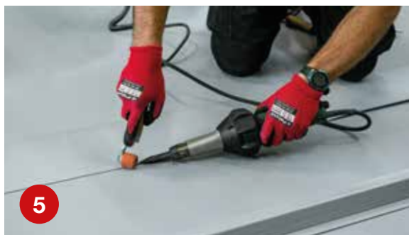
5 Soldar a quente a tira de cobertura da membrana, que deve ter 180 mm de largura para vedar a linha de fixação, aliviando a pressão sobre a membrana existente.
