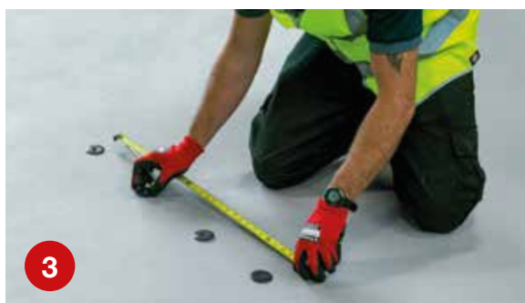
3 Aplique os fixadores corretos para a aplicação nos centros determinados por um cálculo de carga de vento, se necessário.
