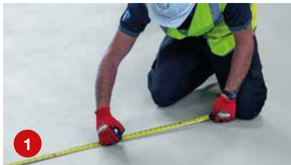
1 Meça e marque com precisão a área de instalação do "EJOBAR TPO 2G".
