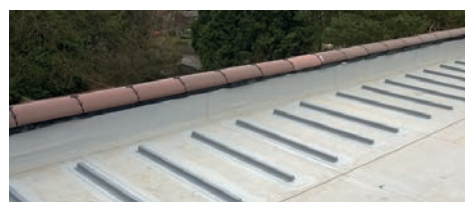
EJObar posicionado corretamente sobre a tira da membrana.
